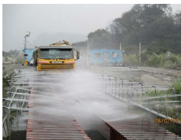
河床運輸便道設置自動洗車台
