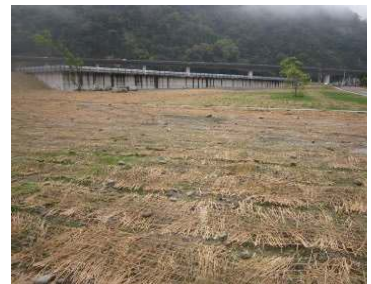
大型裸露地進行稻草蓆覆蓋
