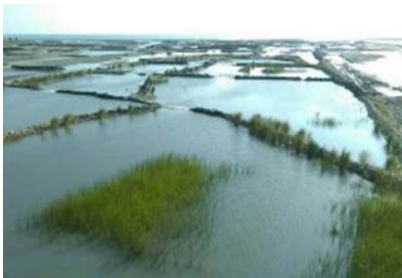
水覆蓋工法施作
