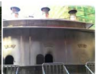
設置金爐防制設備
