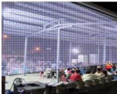
域圍網噴霧系統除油煙
