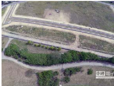
UAV 監控空拍查獲工地污染
