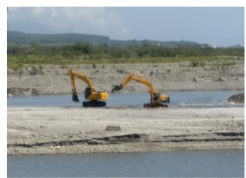
河床進行水覆蓋施作
