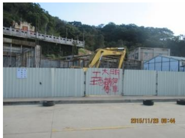
強化營建工地圍籬防護
