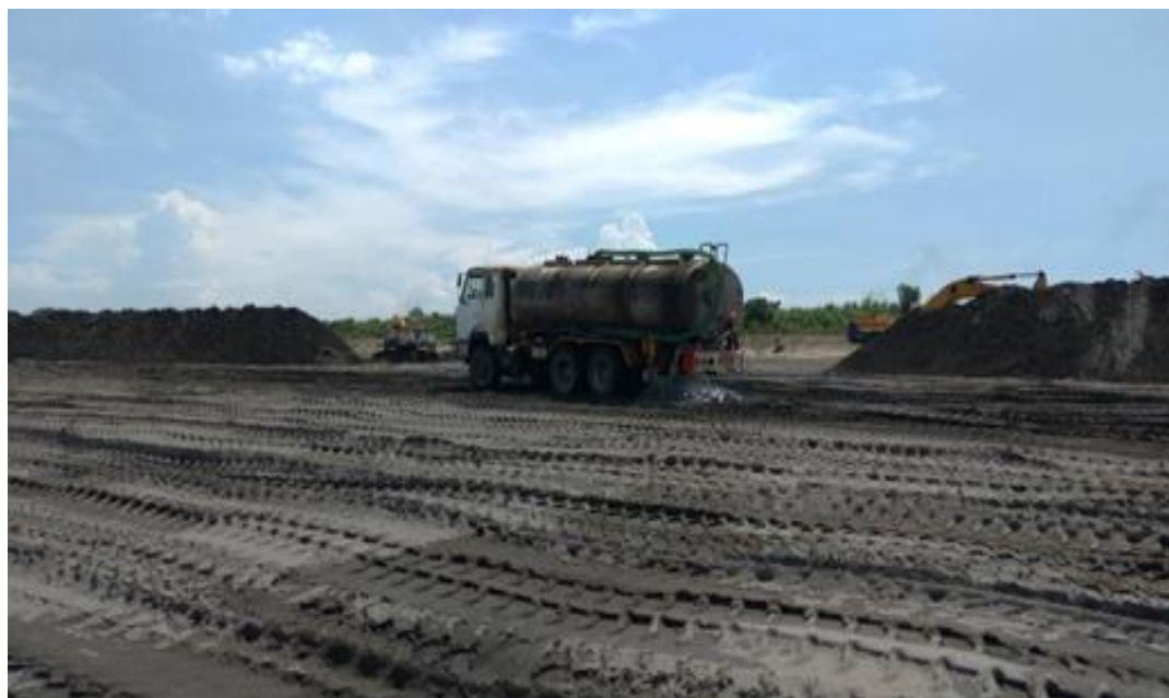
圖28、南水局攔河堰沿岸工地灑水作業
