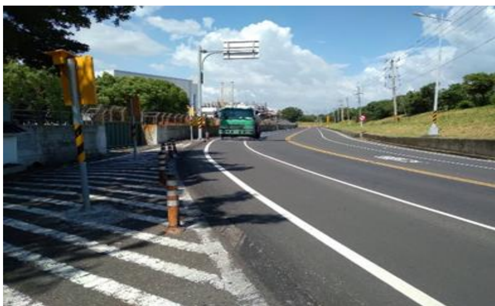
圖29、派遣水車進行台29線灑水作業
