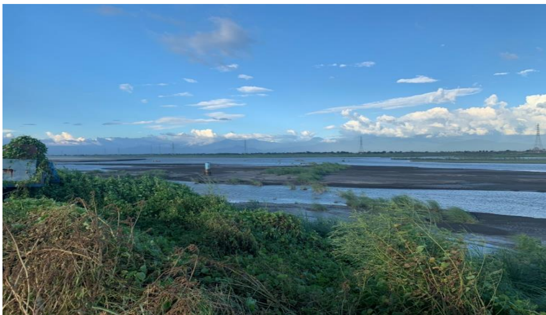
圖32、巡查照片-大寮區潮寮里河段(17時13分)
