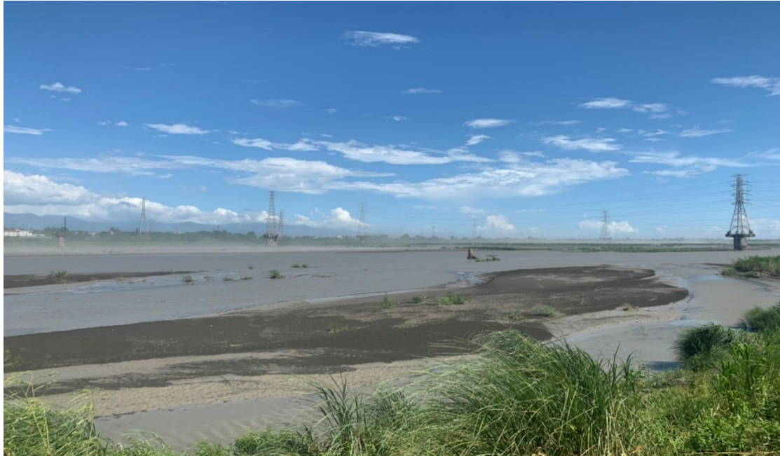
圖31、巡查照片-大寮區潮寮里河段(14時30分)
