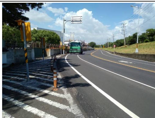
揚塵計畫回報： 15時43分 派水車灑水
