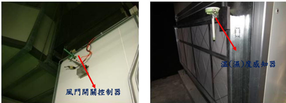
圖 36 空調控制與感知裝置的檢修與維護
