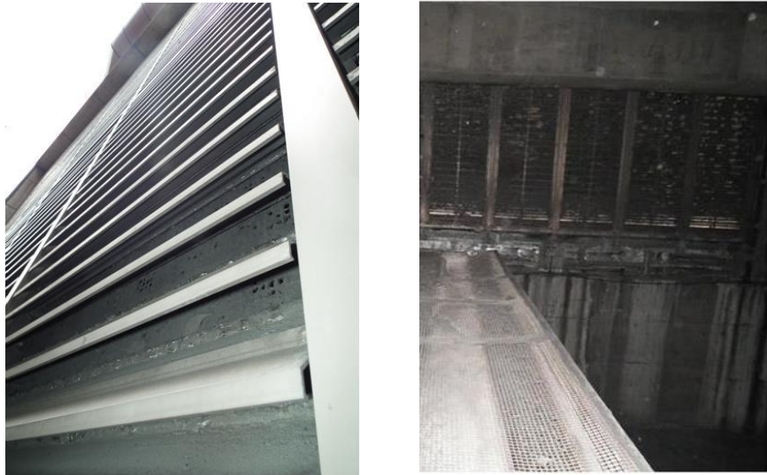
圖 29 外氣進氣口髒污與阻塞情形
