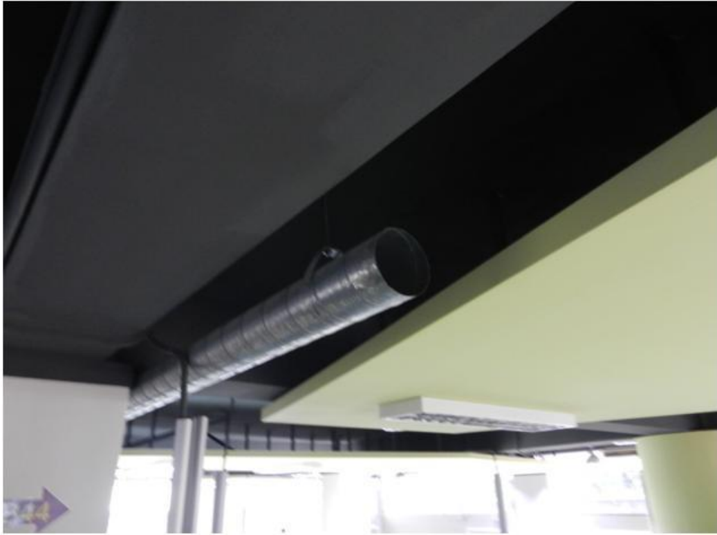
圖 10 外氣輸送風管之出風口不具有風門
