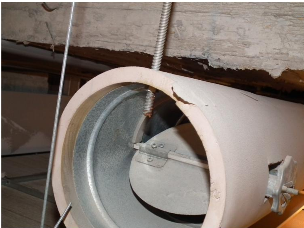
圖 11 外氣輸送風管之出風口具有手動可調式風門
