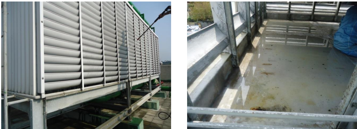
圖 30 冷卻水塔維護與清潔
