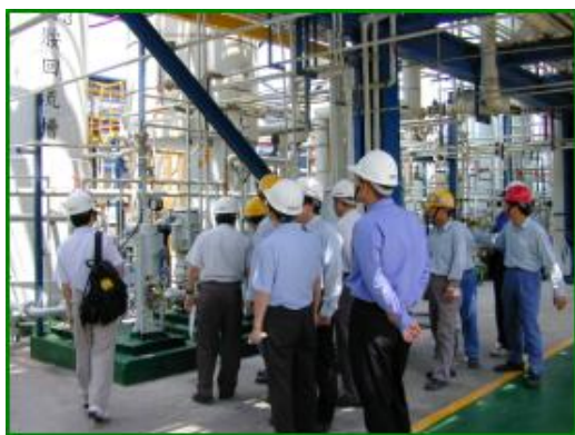
■邀請環工化工專家現場勘查
