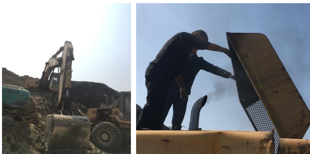
圖4-7 挖土機外觀及排煙狀況
