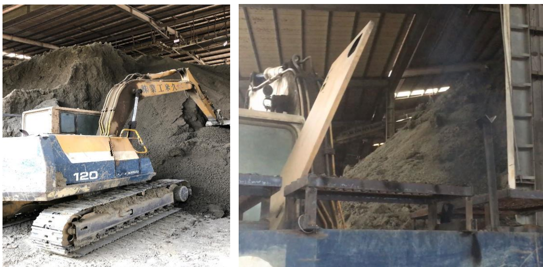
圖4-5 挖土機外觀及排煙狀況
