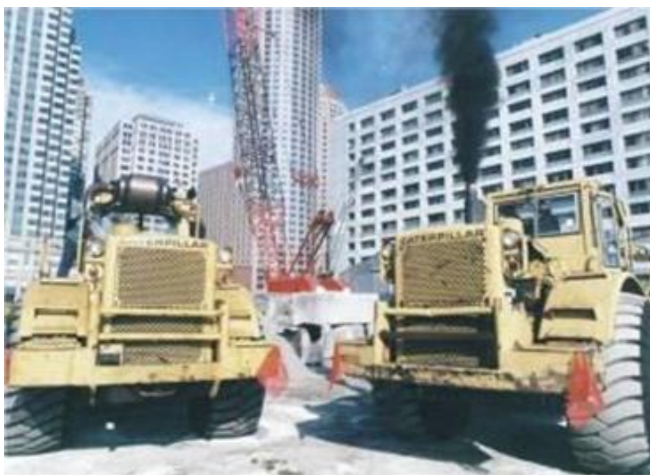
圖3-3 使用濾煙器可改善機具黑煙排放【7】
