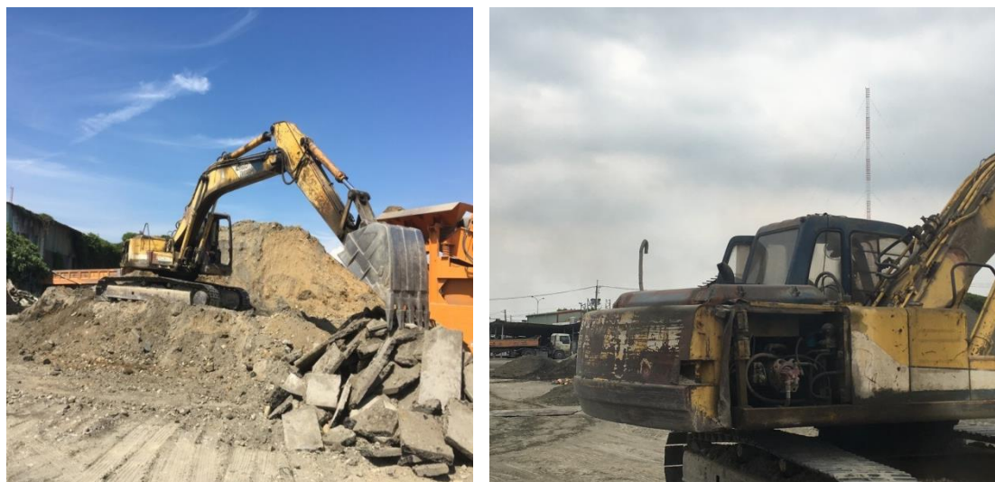
圖4-9 挖土機外觀及排煙狀況
