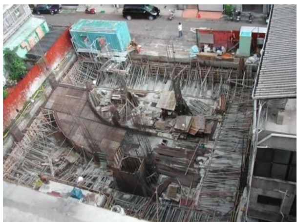
建造階段（施工前）
