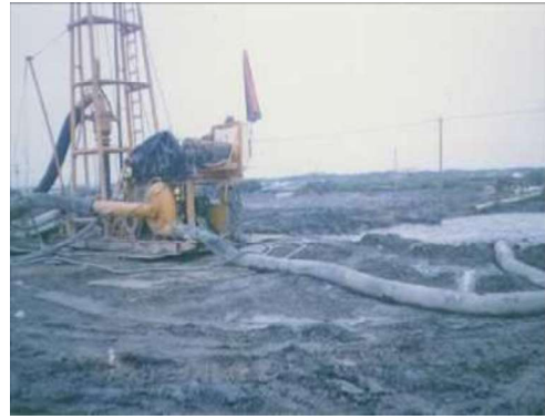
圖 8 反循環工法
