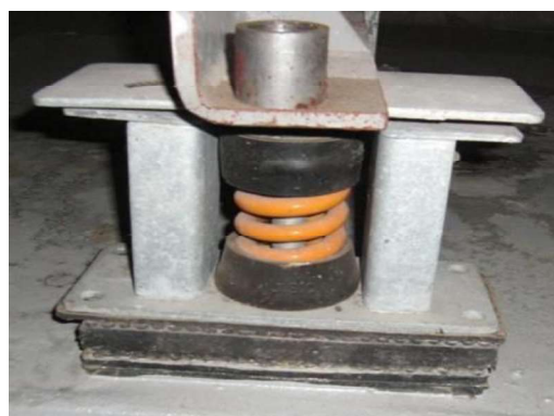
圖 13 機座底部加裝防振設備
