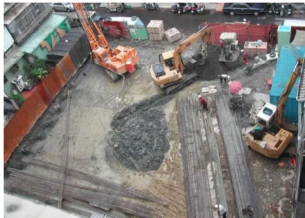
基礎階段（施工中）
