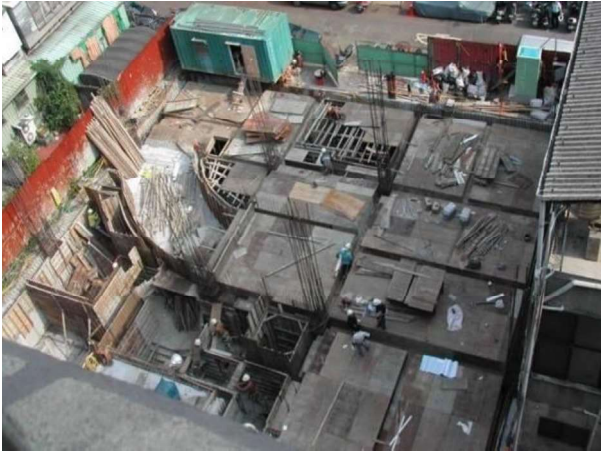
建造階段（施工中）
