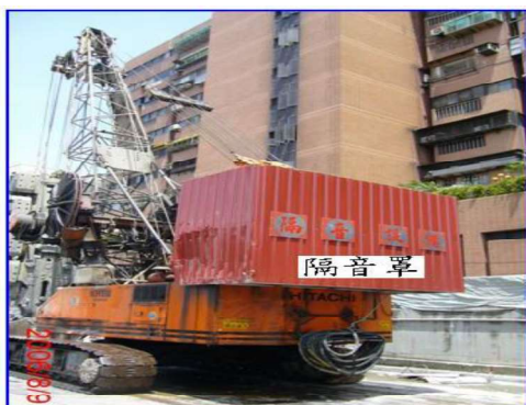
圖 12 機具部分設備加裝隔音罩
