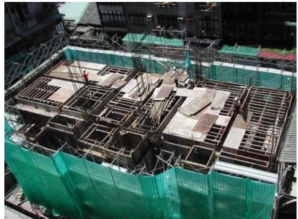
建造階段（施工中）
