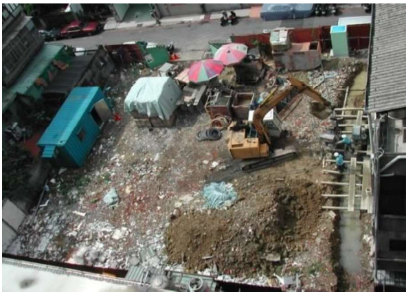
基礎階段（施工前）
