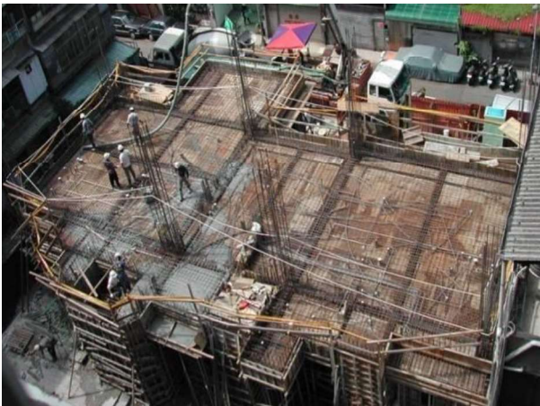
建造階段（施工中）
