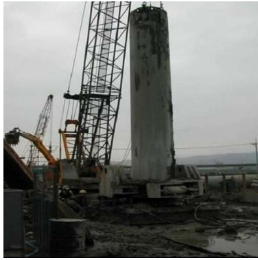
圖 7 全套管工法
