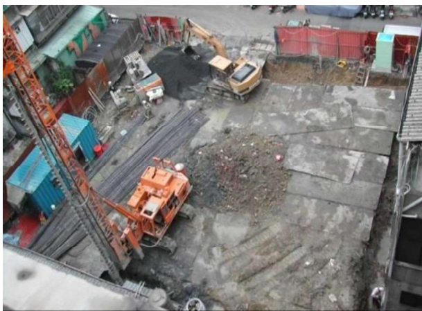
基礎階段（施工中）
