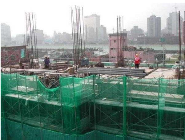
建造階段（施工後）
