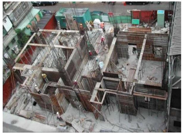
建造階段（施工中）
