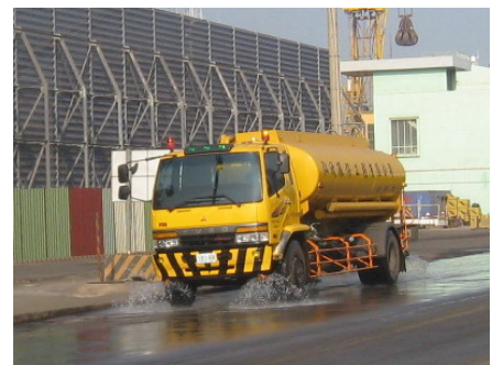
於作業期間灑水，保持路面濕潤
