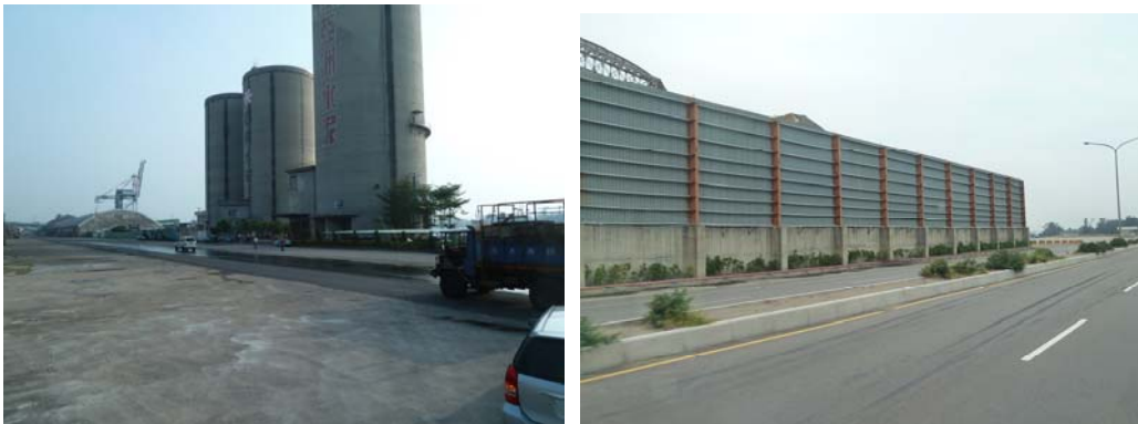
圖3-16 鋪設混凝土及瀝青混凝土實照
