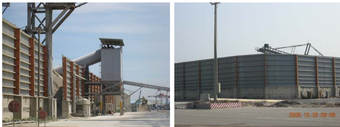
圖3-3 設置鐵皮擋風屏實照
