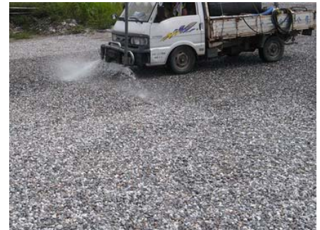
鋪設粗級配或粒料，並於作業期間灑水
