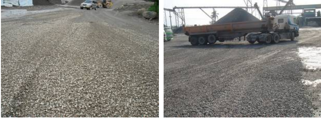
圖3-8 鋪設粗級配實照
