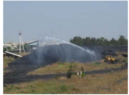
自動灑水設備
