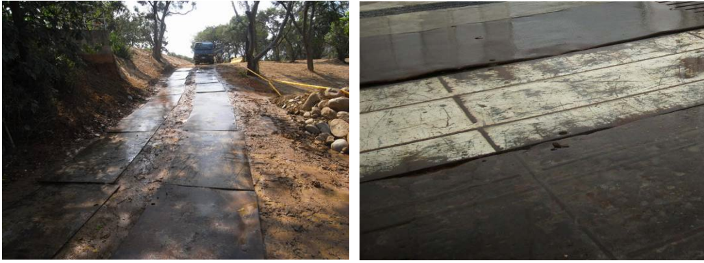
圖3-7 鋪設鋼板實照
