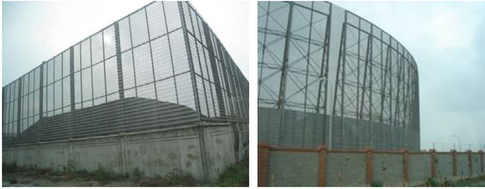
圖3-2 設置混凝土擋風牆實照
