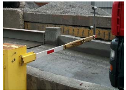
於自動洗車設備出口裝設閘門
