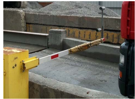
於自動洗車設備出口裝設閘門
