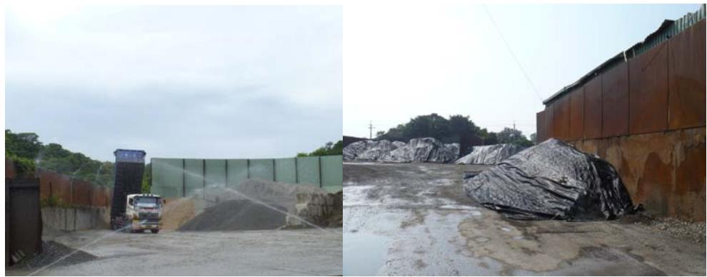
圖3-3 設置鐵皮擋風屏實照
