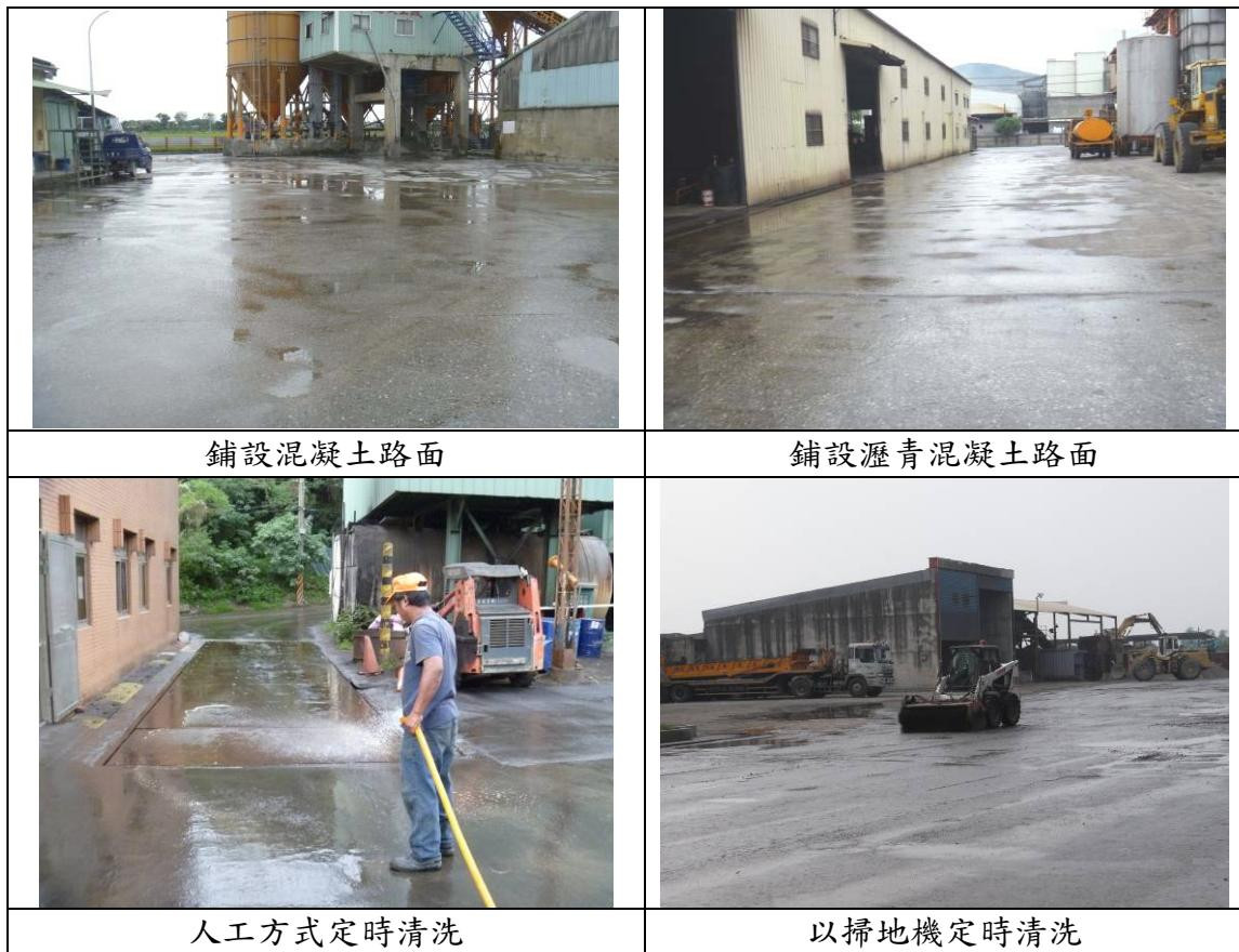
圖 3-16 鋪設混凝土及瀝青混凝土實照
