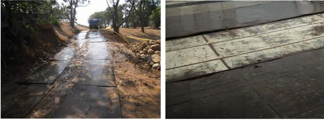
圖3-7 鋪設鋼板實照
