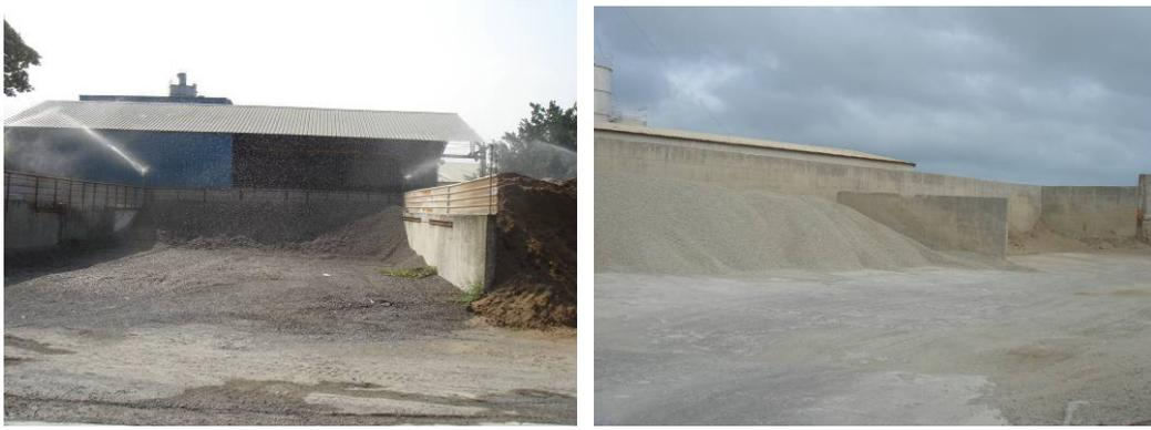
圖3-2 設置混凝土擋風牆實照
