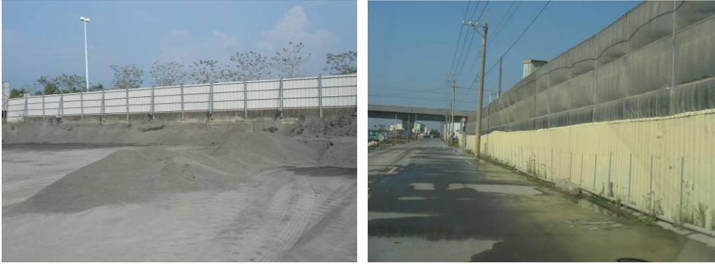
圖3-3 設置鐵皮擋風屏實照
