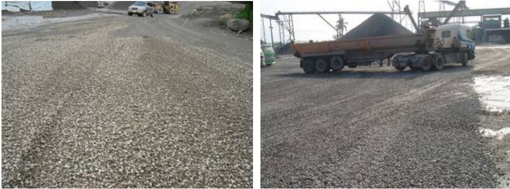
圖3-8 鋪設粗級配實照
