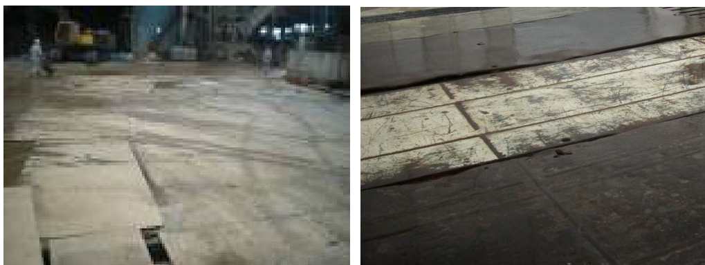
圖3-7 鋪設鋼板實照
