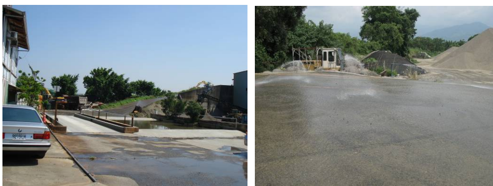
圖3-16 鋪設混凝土及瀝青混凝土實照
