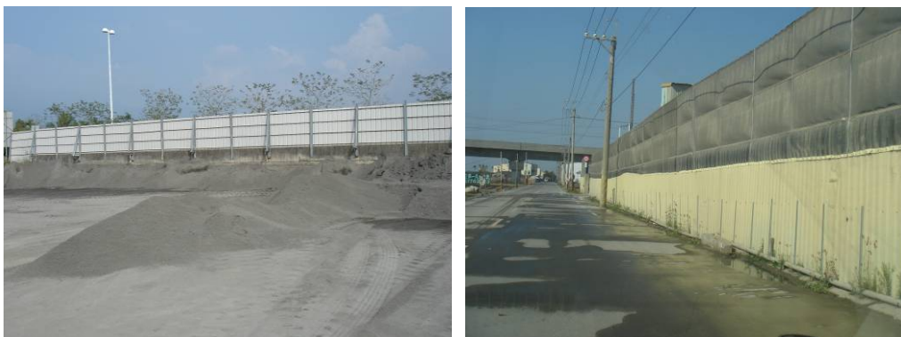
圖3-3 設置鐵皮擋風屏實照
