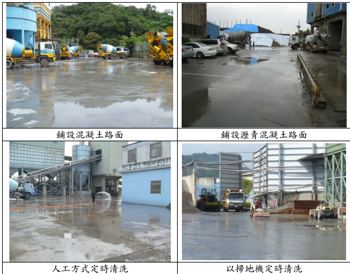
圖3-16 鋪設混凝土及瀝青混凝土實照
