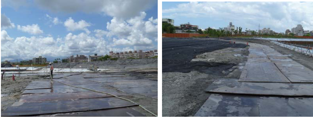
圖3-7 鋪設鋼板實照
