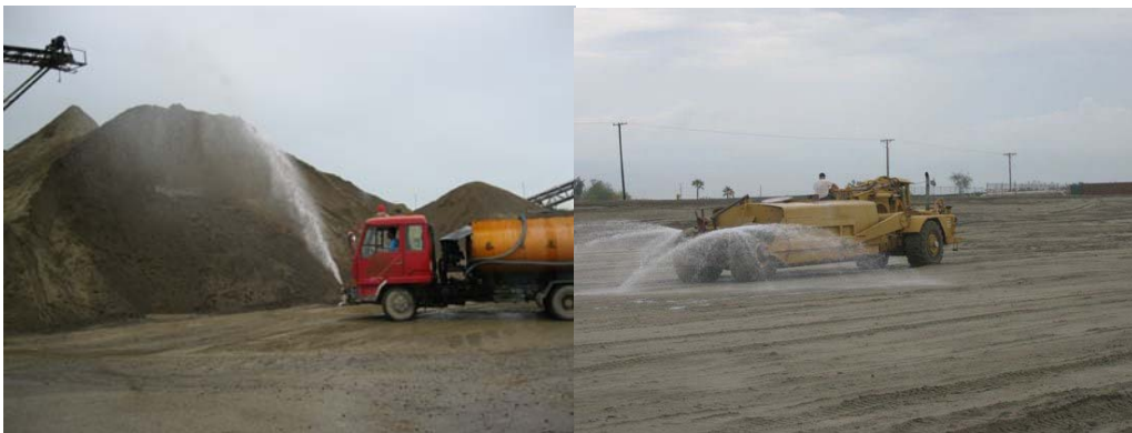
圖3-12 採行灑水車灑水實照
