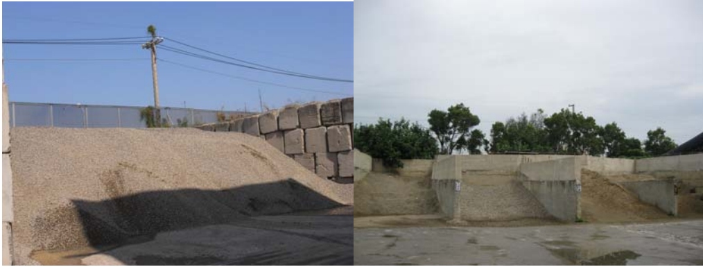
圖3-2 設置混凝土擋風牆實照
