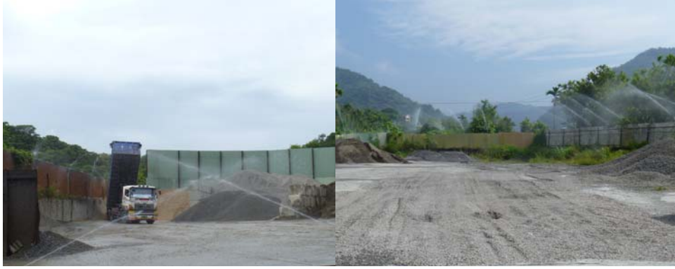
圖3-3 設置鐵皮擋風屏實照
