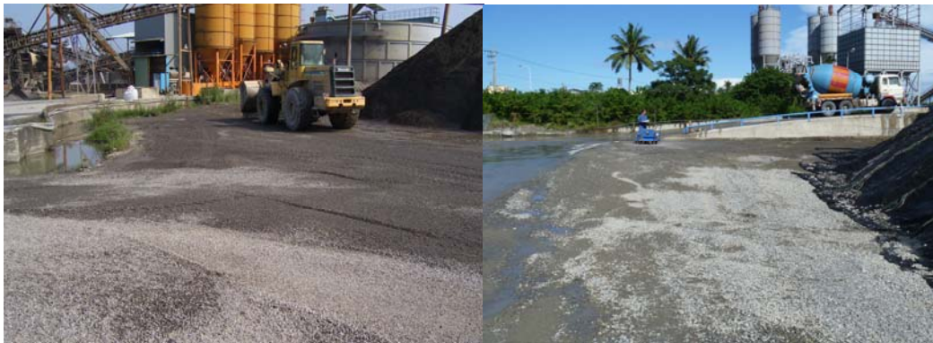
圖3-8 鋪設粗級配實照
