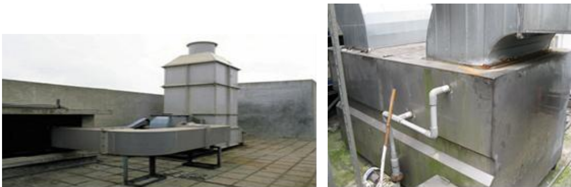
圖 3-5、濕式洗滌設備（水洗機）示意圖
