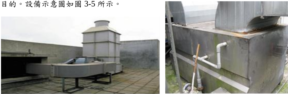
圖 3-5、濕式洗滌器（水洗機）示意圖
