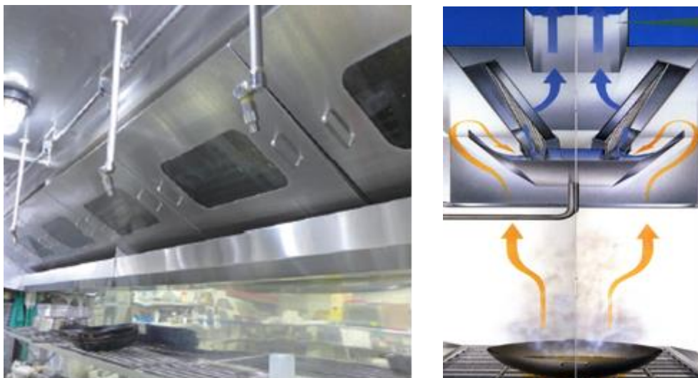
圖 3-3、水幕式煙罩示意圖
